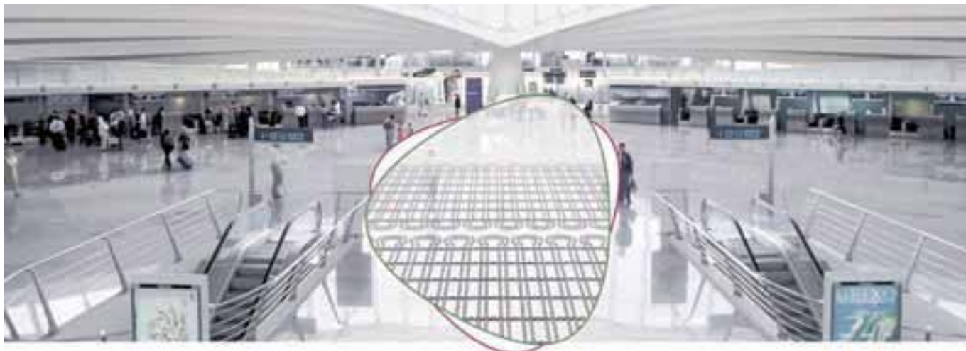
Aquecimento/arrefecimento por superfícies radiantes da REHAU no aeroporto de Bilbau
